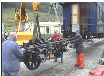
In Realp wird der Kasten auf die Drehgestelle gesetzt
