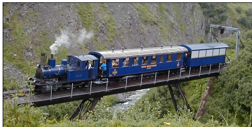
Erste Fahrt über die Steffenbachbrücke
